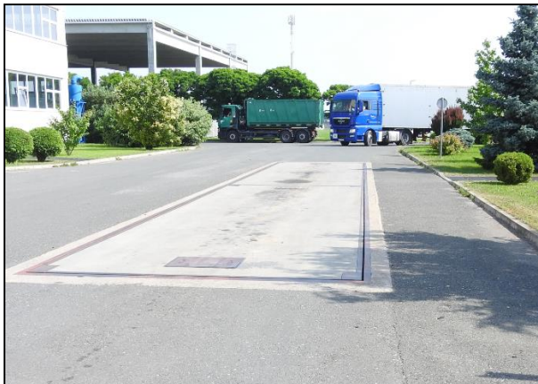
Kolna vaga na ulazu na lokaciju gospodarenja otpadom
