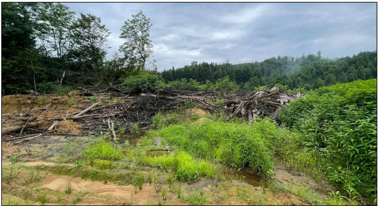
Slika 16 Odložena debla porušenih stabala na istočnom dijelu južne plohe koja će se morati ukloniti prije nastavka odlaganja (fotografija Maxicon d.o.o.)
