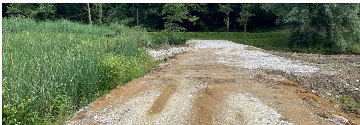
Slika 2 Izvedeni zagat lagune 1 na jezeru, s lijeve strane vidljivo stanje očuvanoga tršćaka (fotografija Maxicon d.o.o.)
