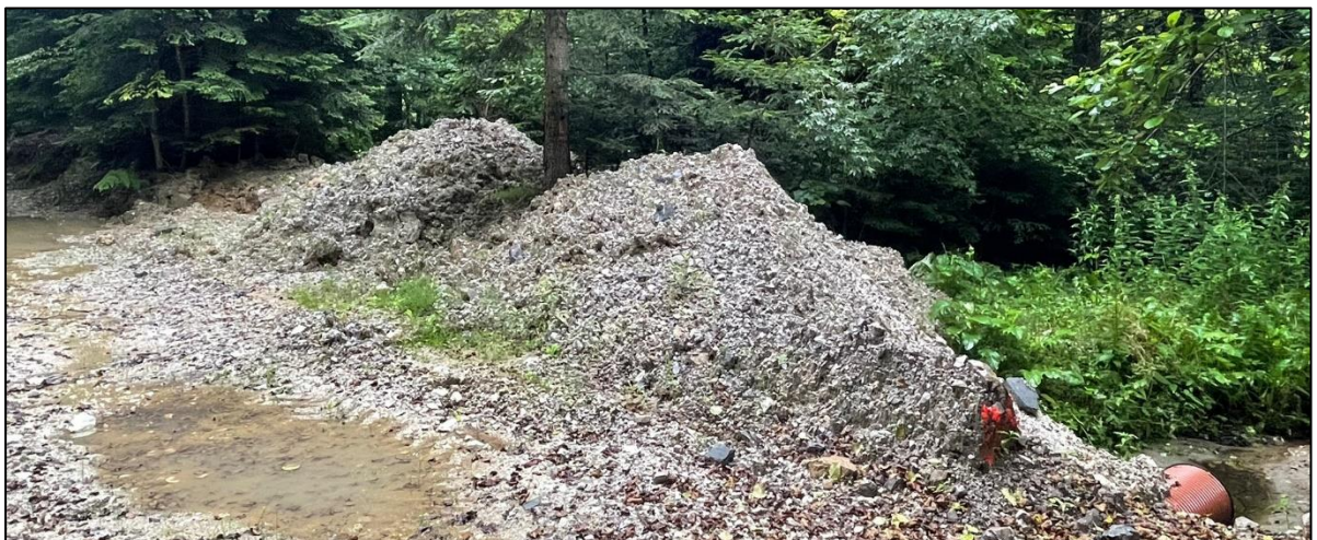
Slika 12 Zatečeni suvišni materijal od iskopa šumskog puta, ostavljen uz put (fotografija Maxicon d.o.o.)
