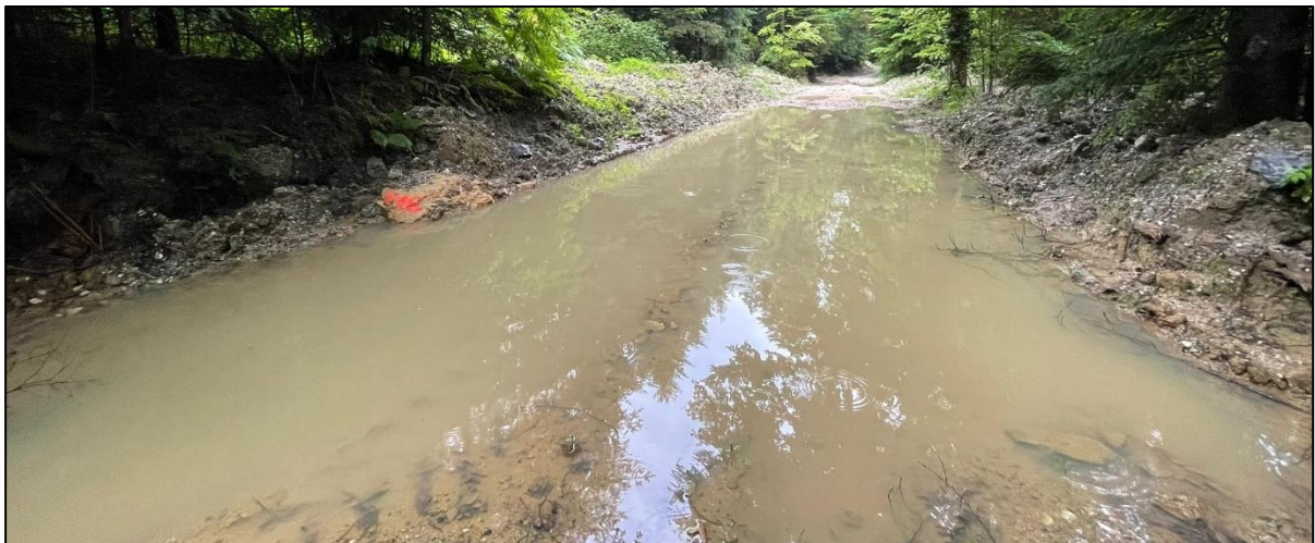
Slika 8 Stanje šumskog puta početkom srpnja 2023., koji je potrebno sanirati za nastavak radova na čišćenju jezera, a kako bi se mogao koristiti za daljnji prijevoz sedimenta od jezera do plohe za prosušivanje (fotografija Maxicon d.o.o.)
