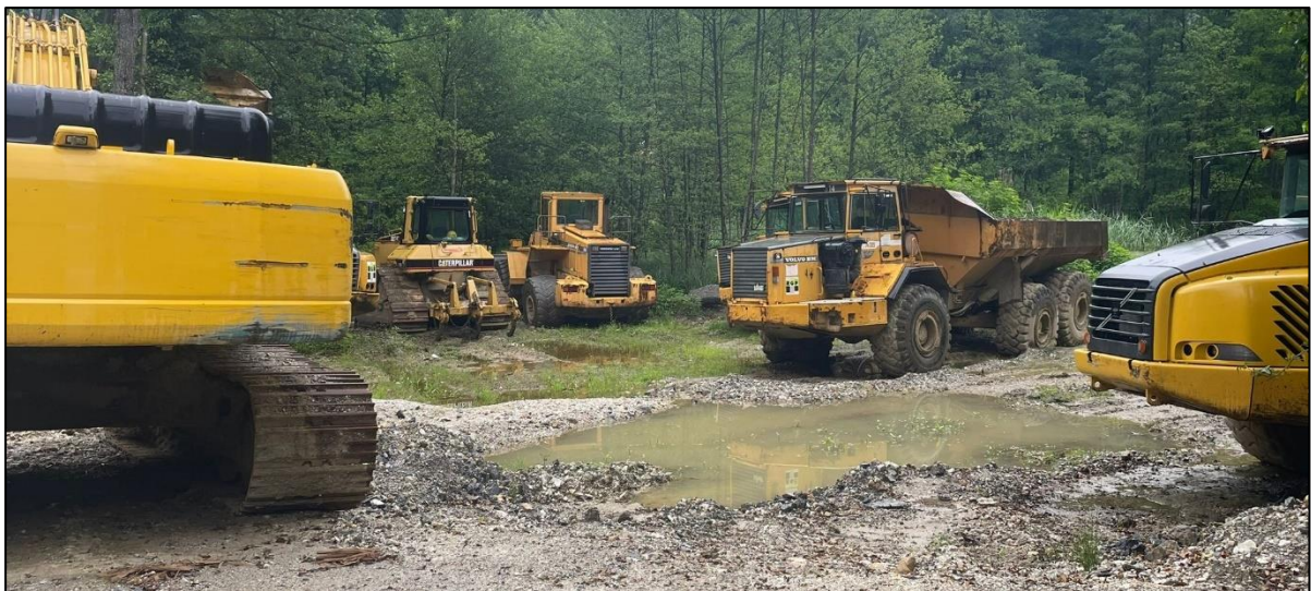
Slika 10 Parkirani strojevi bivšeg izvođača radova na spoju šumskog puta i ŽC2258 (fotografija Maxicon d.o.o.)
