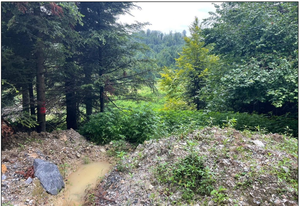
Slika 17 Zatečeno stanje rampe 1 ukazuje na potrebu sanacije prije nastavka radova privremenog odlaganja (fotografija Maxicon d.o.o.)
