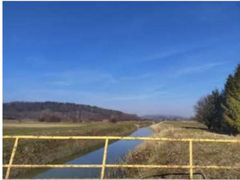
Pogled na lokaciju planirane retencije s mosta na ŽC2101
