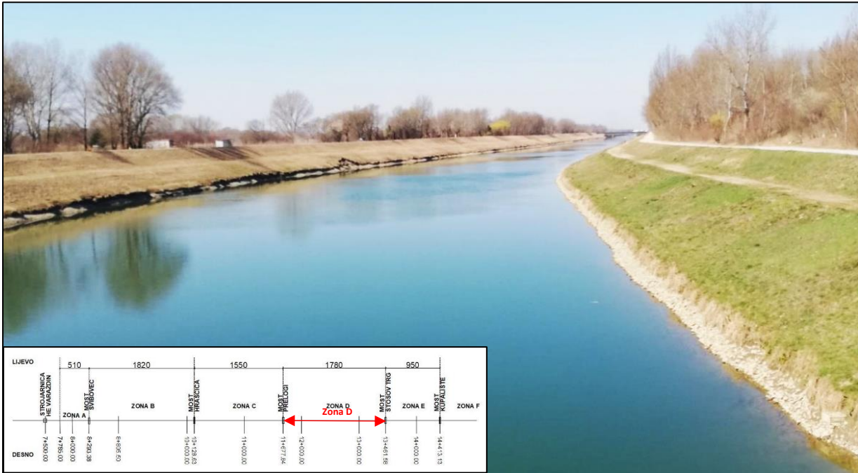
Slika 6. Zona D – pogled s mosta Štosov trg prema mostu Prelogi
